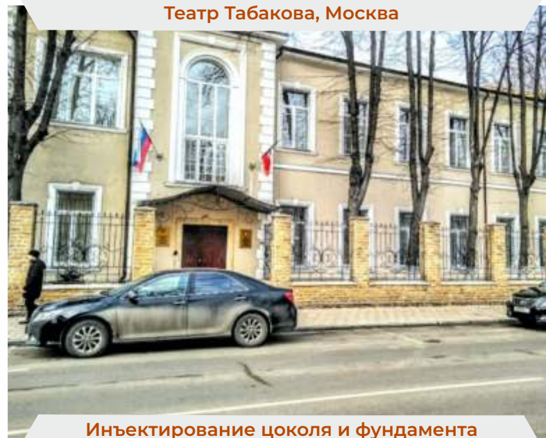
Усиление конструкций и фундамента Театр Табакова, Москва
